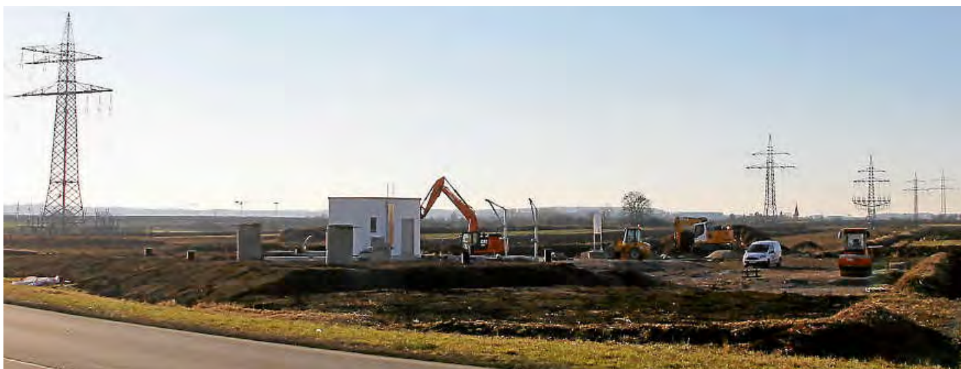
Am Ortsrand von Scharnhausen entsteht ein neues Gewerbegebiet.
